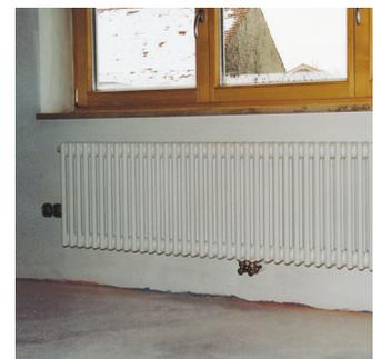
**Hahnblock setzen:** Je nach Heizkörpertyp Wandabstand festlegen, Heizleitungen ablängen und Hahnblock setzen. Dies kann auch vor den Estricharbeiten durchgeführt werden, um so die Heizanlage während der Estricheinbringung unter Druck zu halten.
