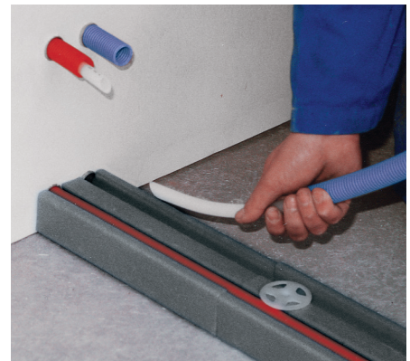
Einführen der Anschlussleitung in den PEBE-Block
