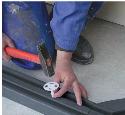
Befestigungsdübel schlagen und Montisol-Streifen bis an den Heizkörperanschluss heranfahren
