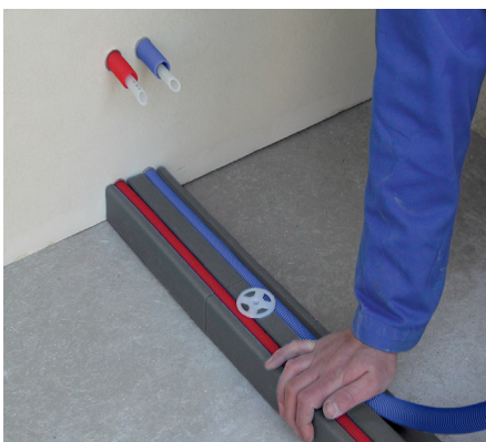
Eindrücken der „Rohr in Rohr“-Heizleitung in den Montisol-Streifen
