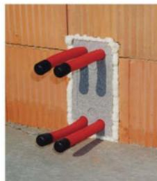
PEBE 2-280 CU Anschlussblock mit PU-Schaum fixiert vor Abschluss der Putzarbeiten. Schutzrohr und Putzkappen schützen vor Mörtel.
