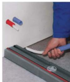
Heizkörper-Anbindungsleitungen nach Putzarbeiten und vor Estrichverlegung – einfach durch den PEBE-Block schieben mit Kunststoffrohr und Montisol DUO 25-100/50.
