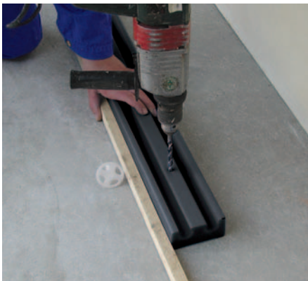
Anschlag zur Wand parallel ausrichten, Montisol auflegen und Befestigungsloch bohren
